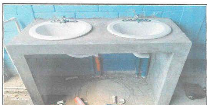
foto 18. Sustitucion de lavamanos
