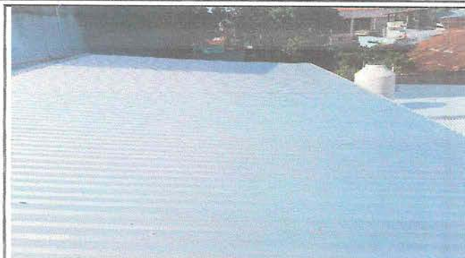
Foto 2. Cambio de lamina por lamina troquelada c 26
