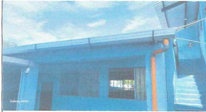
foto 13. Sustitucion de Canal y tubo de aguas pluviales
