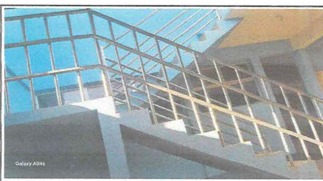
Foto 10. Reparacion de baranda de gradas.
