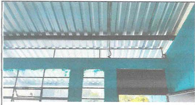
Foto 15. Instalacion de reja de cedazo para evitar que entre paloma a salon de clases
