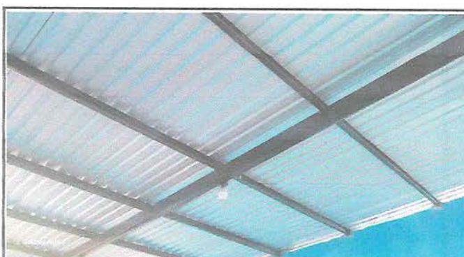
Foto 3. Mantenimiento y pintura de Estructura de Techo, cambio de lamina por lamina troquelada
