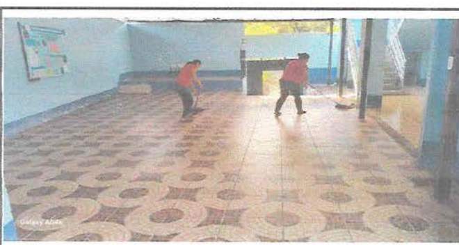
foto 12. Sustitucion de piso Antideslizante en patio techado
