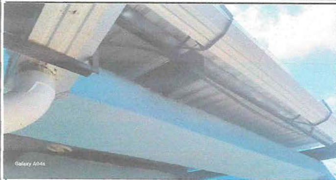
Foto 1. cambio de Canales
